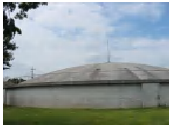
若柴配水場 4号配水池
