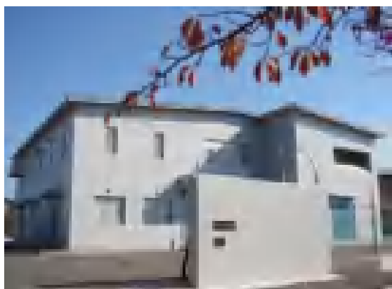
牛久配水場 管理棟
