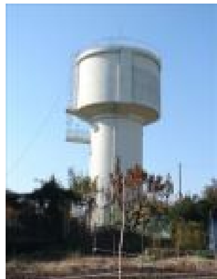
布川台配水塔
