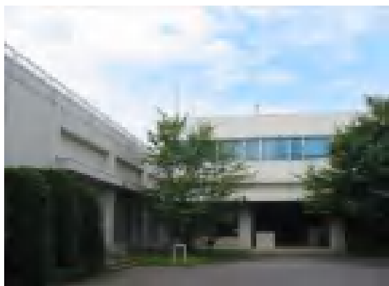
若柴配水場 管理棟
