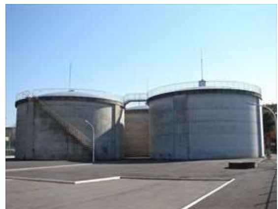
牛久配水場 配水池
