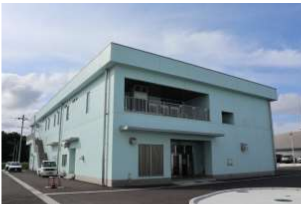
若柴配水場 1系配水ポンプ棟
