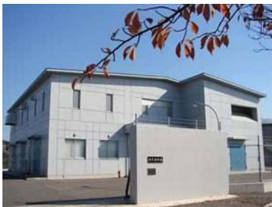
牛久配水場 管理棟
