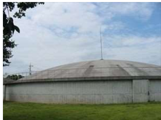
若柴配水場 4号配水池
