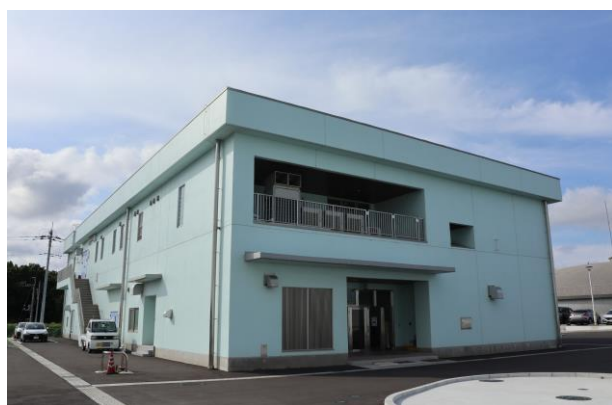
若柴配水場 1系配水ポンプ棟
