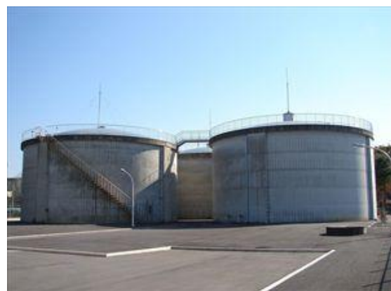
牛久配水場 配水池
