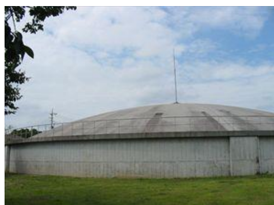
若柴配水場 4号配水池
