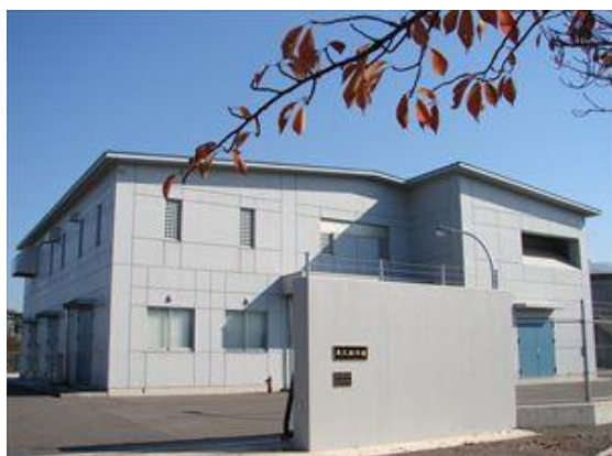
牛久配水場 管理棟
