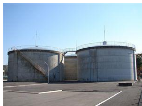
牛久配水場 配水池
