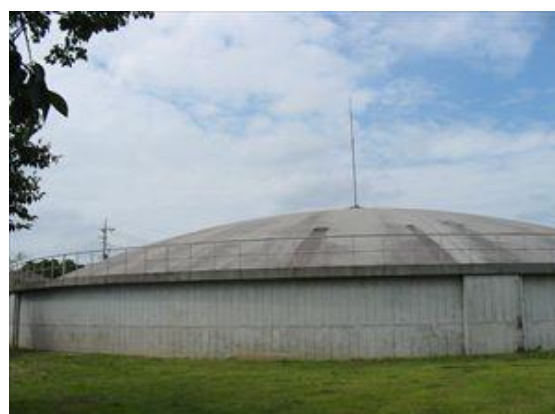
若柴配水場 4号配水池
