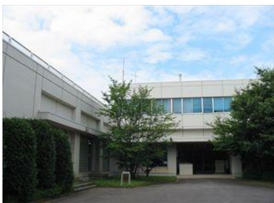
若柴配水場 管理棟
