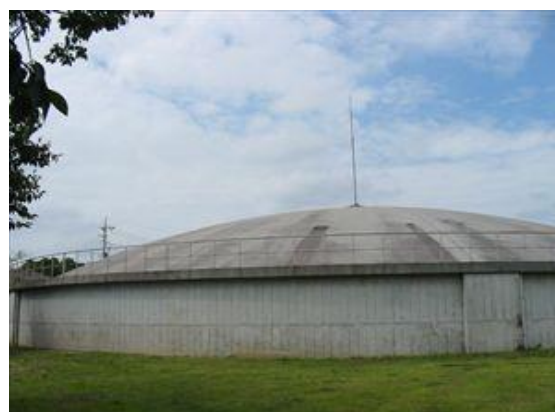
若柴配水場 4号配水池
