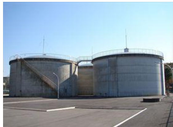
牛久配水場 配水池
