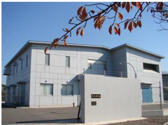
牛久配水場 管理棟
