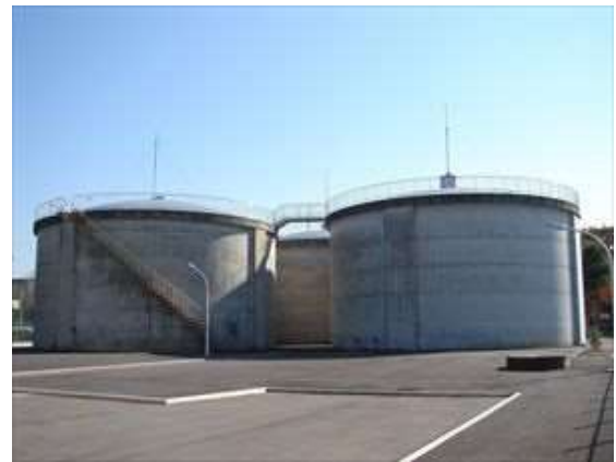
牛久配水場 配水池
