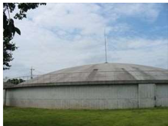
若柴配水場 4号配水池
