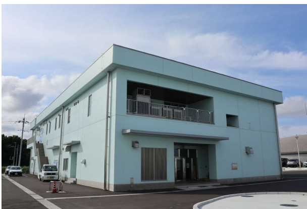
若柴配水場 1系配水ポンプ棟
