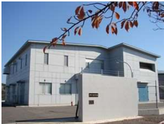
牛久配水場 管理棟
