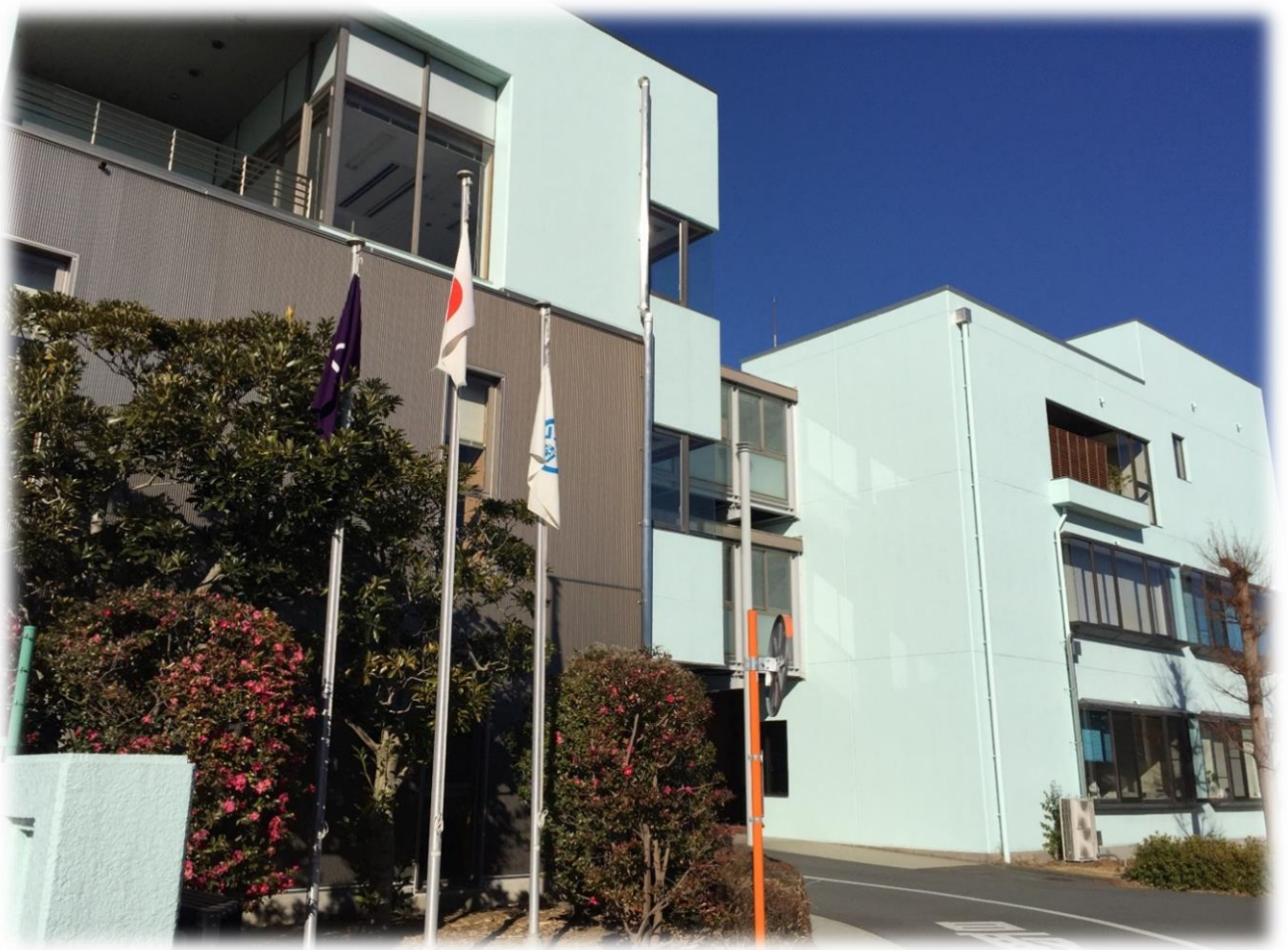
茨城県南水道企業団事務所棟
